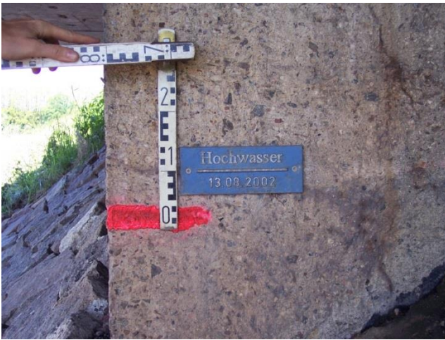
Abb. 5: Markierter Hochwasserstand des Junihochwassers 2013 an vorhandener Hochwassermarke
